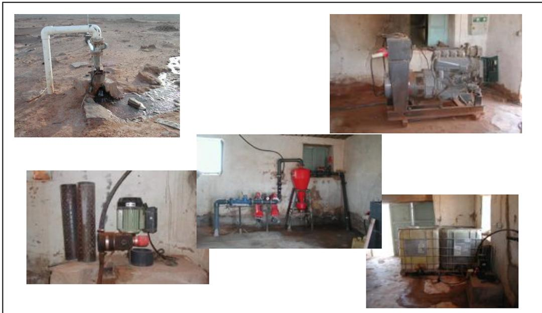
Figura 4. Sistema de bombeo fósil: bomba de gasoil con filtro para el Huerto de Extremadura en Dajla. Los filtros de arena que se aprecian en la foto central deben ser limpiados cada dos días.
